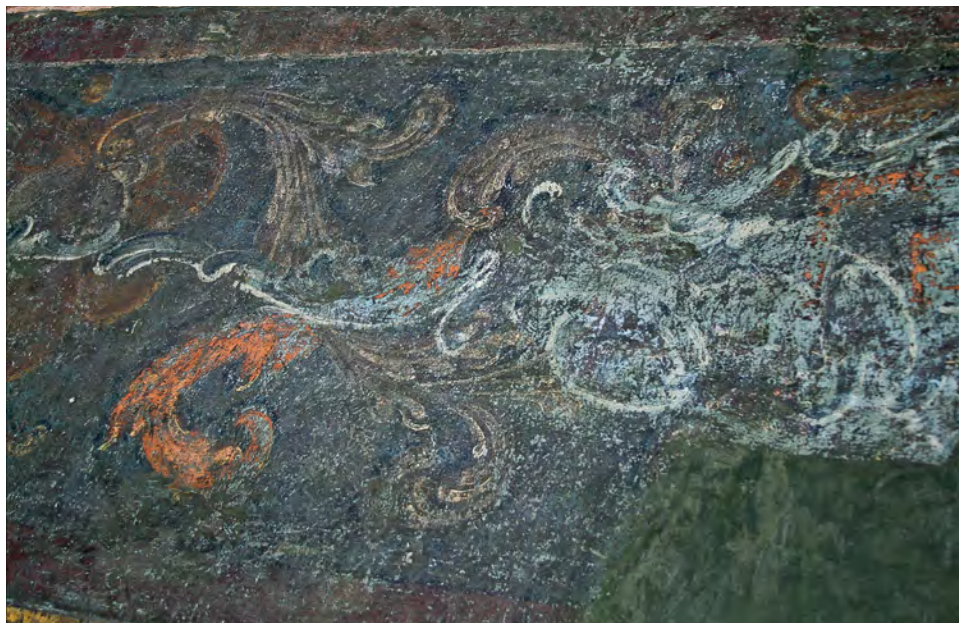
Il. 15 Pomieszczenie w trakcie tylnym parteru. Odslonięty spod XIX-wiecznych przemalowań ornament rocaillowy plafonu i leżący pod nim ornament okuciowo-pasowy, fot. S. Socha-Bystróż
