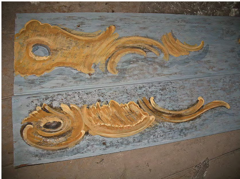
Il. 18 Belki stropu z XVIII-wieczną polichromią. Nad belkami widoczne dyle z XIII w. pokryte warstwami malarskimi, fot. A. Bystróż-Kwiatkowska
