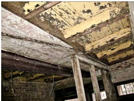
Il. 2 Strop belkowo-deskowy Wysokiej Sieni w trakcie odsalania spod oszalowania, fot. S. Socha-Bystroń
