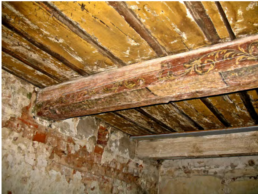
Il. 19 Pomieszczenie I piętra w tylnym traktcie. Pomieszczenie I piętra w tylnym traktcie. Rocaille-owa dekoracja stropu w trakcie prac konserwatorskich, fot. A. Bystróż-Kwiatkowska
