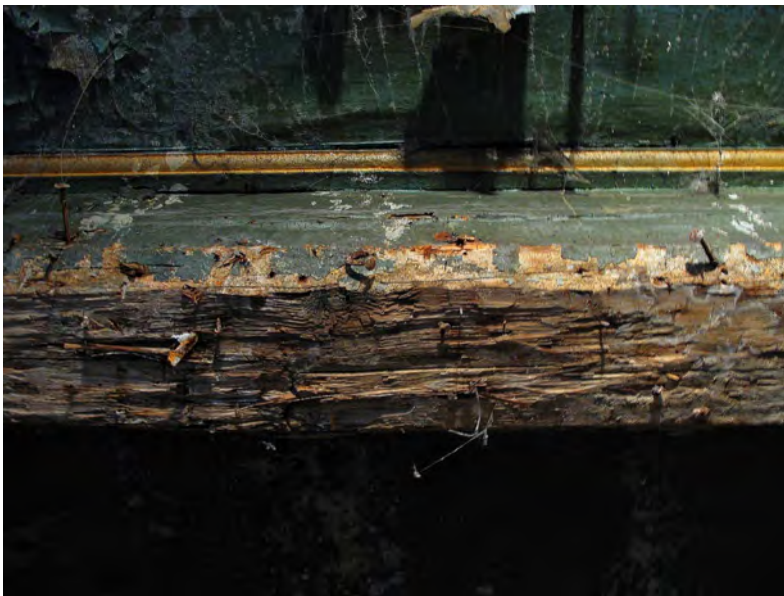
Il. 5 Pomieszczenie w trakcie tylnym parteru. Obciosane belki stropu, fot. L. Czyżniewska
