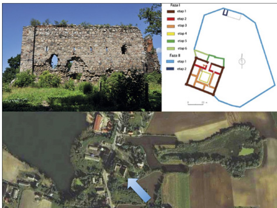
II. 2. PĄPOWO BISKUPIE, zamek kapitulny. Widok skrzydła wschodniego, rozwarstwienie chronologiczne murów i widok zamku z lotu ptaka. Fot. W. Miłek; oprac. etapów budowy B. Wasik; widok z lotu ptaka wg Google Maps
