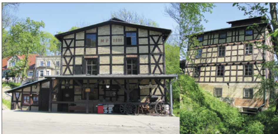
Il. 2. GRUCZNO, młyn wodny, elewacje południowa i zachodnia (z dostawionym zadaszaniem). Fot. D. Jagiełło
