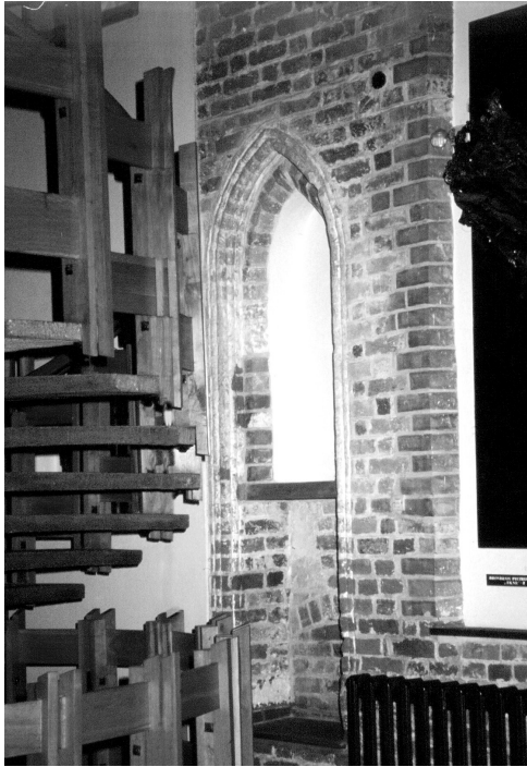
Il. 11 Toruń, kamienica przy ul. Łaziennej 16. Wnęka umywalkowa w dużej sieni, fot. Z. Nawrocki (2012 r.)
