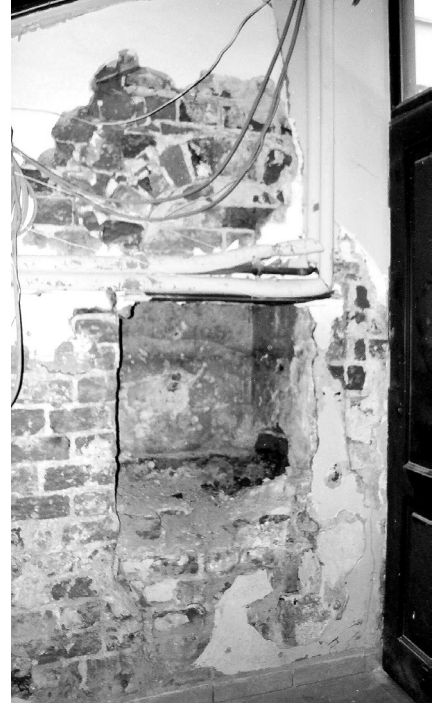
Il. 12 Toruń, kamienica przy Rynku Staromiejskim 4. Wnęka umywalkowa w trakcie tylnym, fot. Z. Nawrocki (2012 r.)
