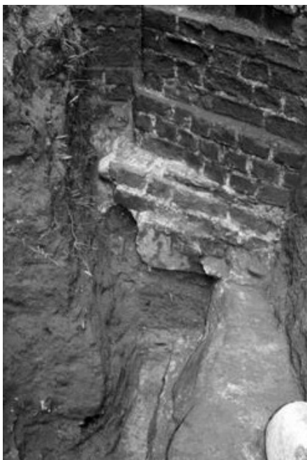
Il. 11 Toruń, kościół św. Jakuba, badania archeologiczne w 2012 roku. Wykop W-10/12 przy bocznym portalu prezbiterium – widok na ceglany fundament wieżyczki schodowej (skośny, w głębi) i (na pierwszym planie) potężny kamienny fundament pod portalem i przyporą, fot. A. Cicha
