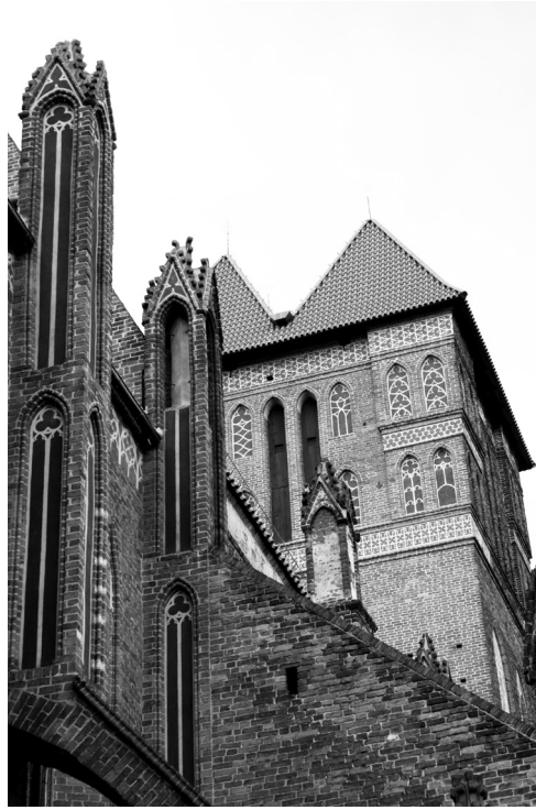
Il. 1 Toruń, kościół św. Jakuba. Bryła kościoła z 1309 roku, widok od północnego wschodu na łuk przyporowy nad zakrystią, pinakle na przyporach i górną partię wieży w masywie zachodnim (stan z roku 2012, w trakcie renowacji), fot. J. Struwe.
