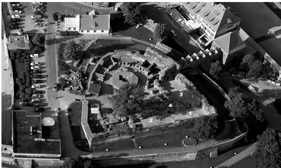
Il. 1 Toruń, ruina zamku konwentualnego w widoku z lotu ptaka: 1 – kościół; 2 – refektarz; 3 – kapituła; 4 – krużganek, fot. A. Skowroński
