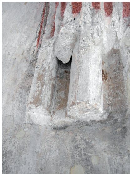
Il. 5 Toruń, kościół pw. św. Jana Chrzciciela i św. Jana Ewangelisty. Splyw sklepienny nawy południowej, warsztat murarski z II poł XV w. – konsola z wykorzystanego wtórnie fragmentu splywu sklepiennego z czasu niskiego kościoła, fot. I. Brzostowska
