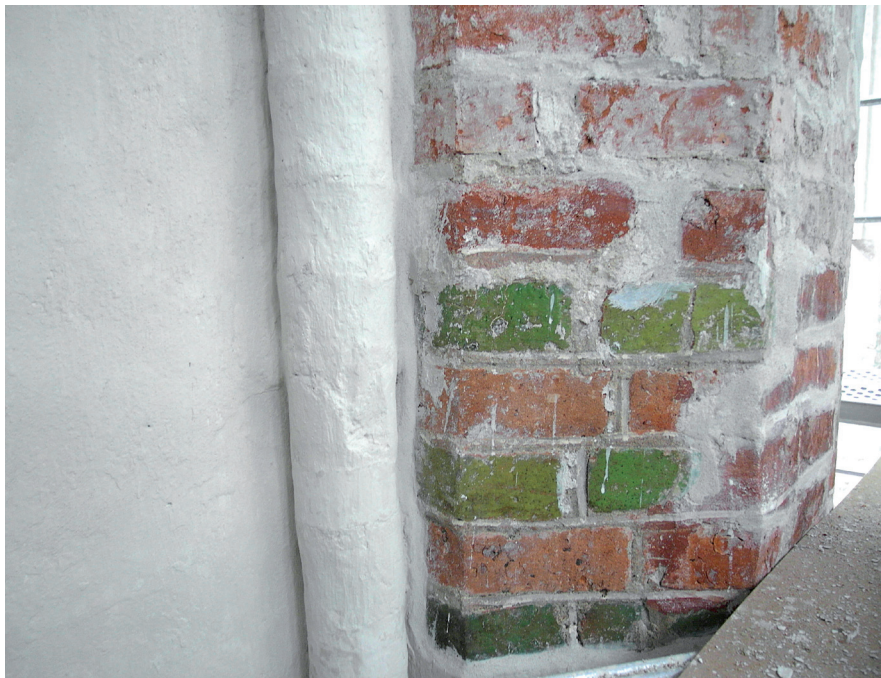
Il. 1 Filar nawy południowej, fragment muru z widocznym opracowaniem murarskim z XIV w. – dolne partie, i XV w. – górne partie, fot. I. Brzostowska
