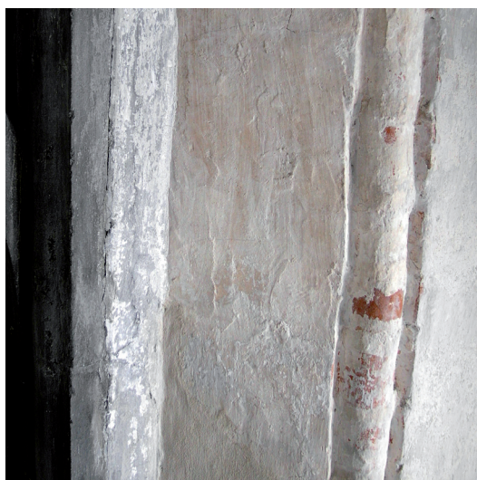
Il. 10 Toruń, kościół pw. św. Jana Chrzciciela i św. Jana Ewangelisty. Głif okna nawy południowej, XV-wieczny warsztat murarski – sposób opracowania powierzchni tynku, fot. I. Brzostowska
