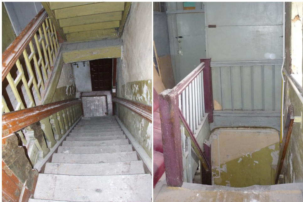
Il. 9 Toruń, Pałac Fengera, główna klatka schodowa w budynku frontowym. Odcinki schodów pochodzące z różnych etapów adaptacji na cele mieszkalne: odcinek z parteru na I piętro z balustradą brusową polichromowaną z 1742 roku; balustrada szczelinowa, kratowa między I a II piętrem powstała w czasie adaptacji na kamienicę wielorodzinną po 1835 roku i odcinek schodów między II a III piętrem z balustradą szczelinową pionową, fot. J. Kucharzewska
