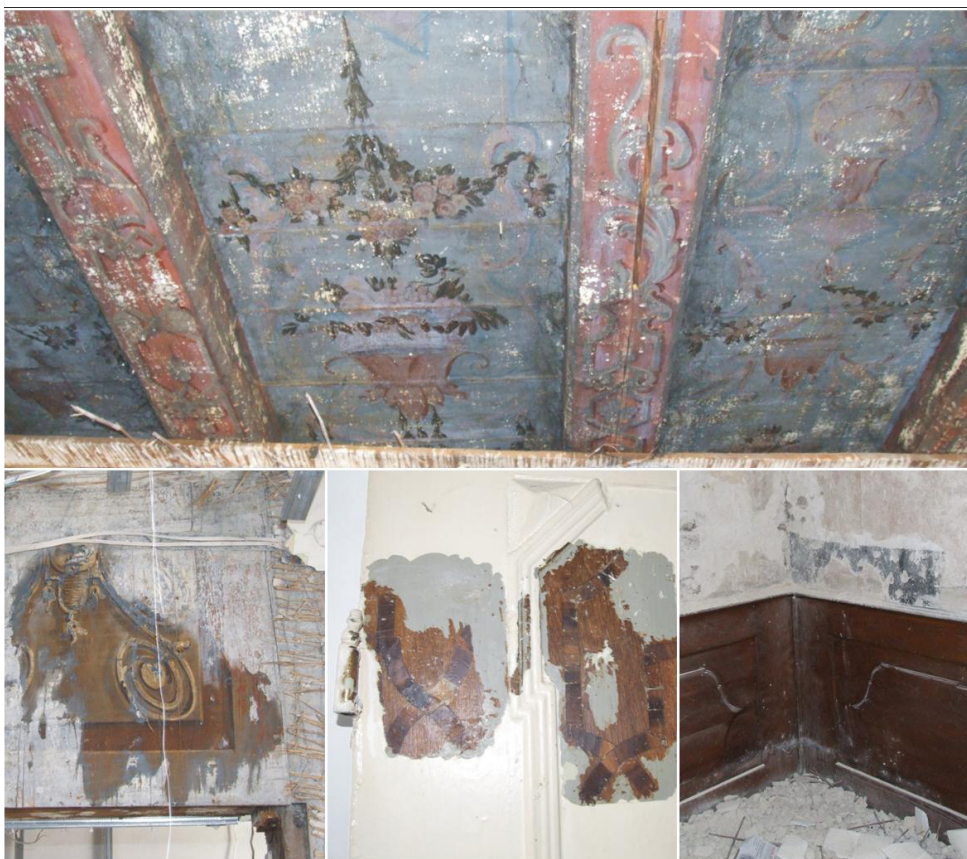
Il. 7 Toruń, Pałac Fengera, zachowane elementy dekoracji i wyposażenia: polichromowany strop w pomieszczeniu południowym na I piętrze, dekoracja ścianek wysokiej sieni, intarsja na drzwiach, boazeria w pomieszczeniu oficyny południowo-zachodniej, fot. J. Kucharzewska
