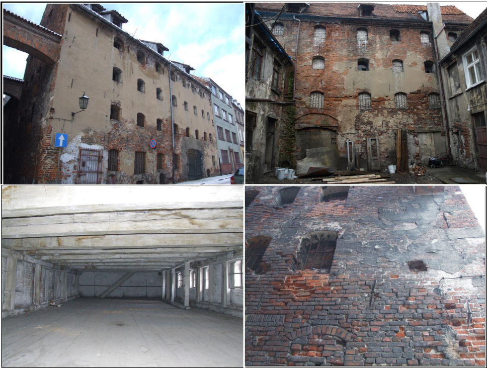
Il. 5 Toruń, spichlerz przy ul. Podmurnej 13. Widok fasady, elewacji tylnej od strony podwórka, fragment wnętrza i zachowane relikty tynkarskiego boniowania, fot. J. Kucharzewska
