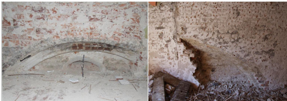
Il. 6 Toruń, zachowane wnętrza wielkich sieni sąsiednich kamienic gotyckich – południowej i północnej. We wnęce od strony ul. Ciasnej wpisane okno. Wnęka kamienicy północnej z przemurowaniem naprawczym z okresu średniowiecznego, fot. J. Kucharzewska
