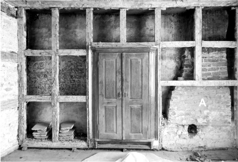
Il. 9 II piętro, trakt tylny. Widok od strony pn.-wsch. na szkieletową ściankę równoległą do muru zach., wprowadzoną najpóźniej na pocz. XIX w. Zachowana klasycystyczna szafka ścienna. A – gotycki komin dawnego kominka niższej kondygnacji, fot. E. Nawrocka
