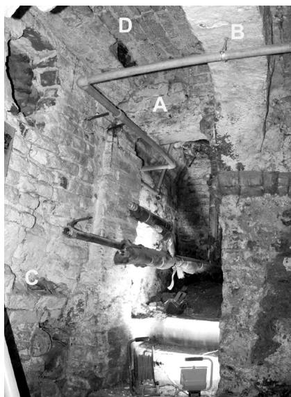
Il. 3 Piwnica, trakt tylny. Narożnik pn.-zach. – miejsce dawnego pieca do ogrzewania izby tylnej parteru. Widok na przejście w murze tylnym do piwnicy pod podwórzem. A – zamurowany otwór do górnej części pieca; B – fragment muru w miejscu usuniętej ściany pieca; C – poziom paleniska; D – sklepienie pieca, fot. E. Nawrocka
