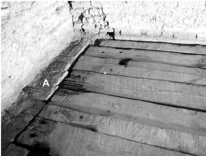
Il. 10 II piętro, trakt tylny, narożnik pn.-wsch. Fragment podłogi z brusów średniowiecznych (XIII w.). A – odsadzka gotyckiego muru tylnego, fot. E. Nawrocka
