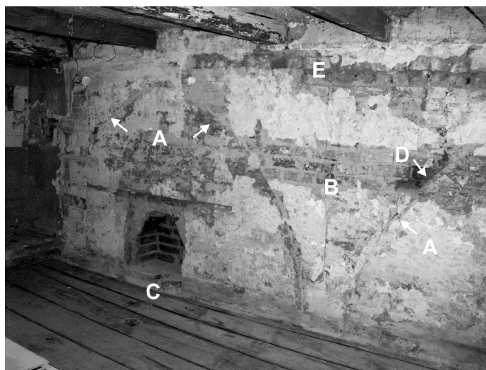
Il. 7 I piętro, trakt tylny. Widok od strony pd.-zach. na mur wsch. A – ślady po sklepieniu parteru, z najstarszego etapu gotyckiego; B – lico przemurowane po likwidacji sklepienia; C – wnęka prawdopodobnie z czasu występowania sklepień; D – odsłonięta odsadzka, na której opierało się sklepienie; E – warstwy główek nad pierwotnym (ob. zamurowanym) wgłębieniem przygotowanym dla osadzenia sklepienia, fot. E. Nawrocka
