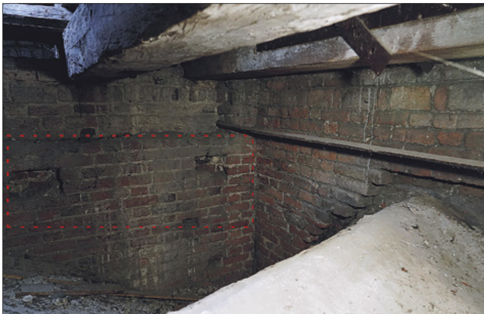
Il. 4. TORUŃ, kościół p.w. Wniebowzięcia NMP, fragment więźby dachowej nad nawą północną, z zaznaczeniem otworów po belkach stropowych, fot. J. Raczkowski
