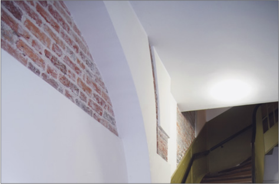
II. 4. TORUŃ, kamienica przy Rynku Staromiejskim 25, klatka schodowa – uczyniony zarys blendy na ścianie dawnej wielkiej sieni po stronie zachodniej. Fot. J. Raczkowski
