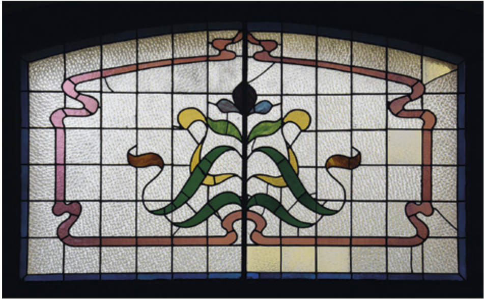
II. 10. Toruń, ul. Poniałowskiego 3, secesyjny witraż nadświetla drzwi wejściowych (szkło opalowe, katedralne, ornamentowe, listwy ołowiowe). Fot. A. Kaźmierczak
