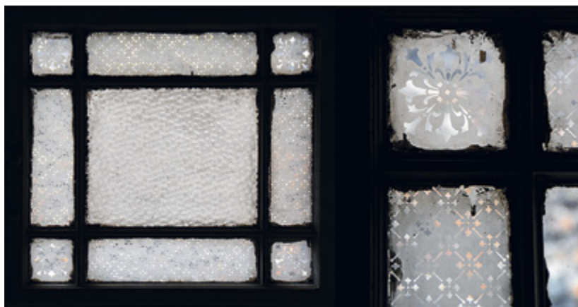
II. 2. TORUŃ, ul. Poniatowskiego 5, szklenie dekoracyjne okna klatki schodowej (szkło muslinowe, rozety matowane, szkło ornamentowe). Fot. A. Kaźmierczak
