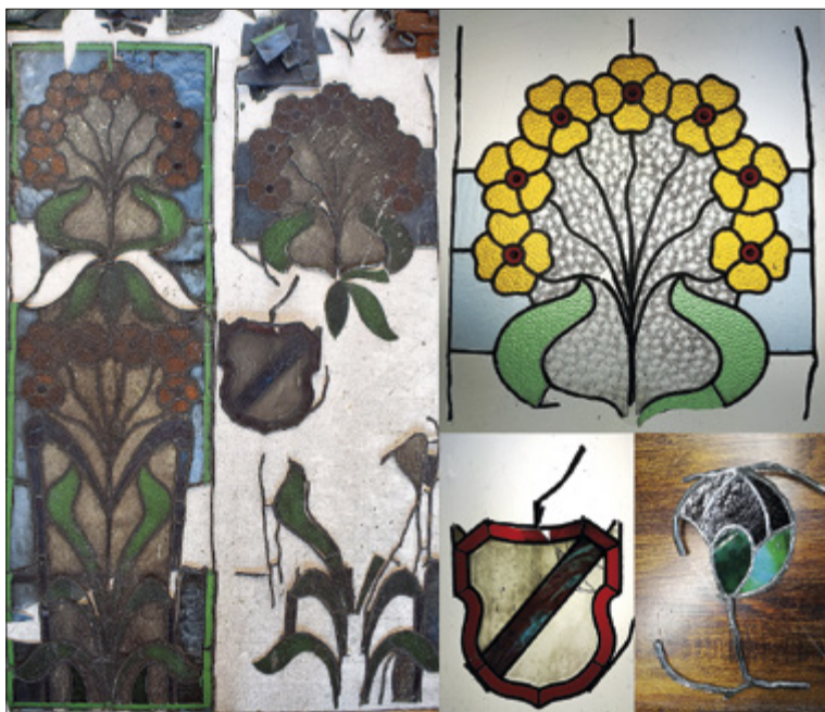
II. 12. TORUŃ, ul. Poniatowskiego 1, znalezione fragmenty secesyjnych witraży z okien klatki schodowej (szkło opalowe, katedralne, ornamentowe, matowane, kaboszony, listwy ołowiane). Fot. A. Kaźmierczak
