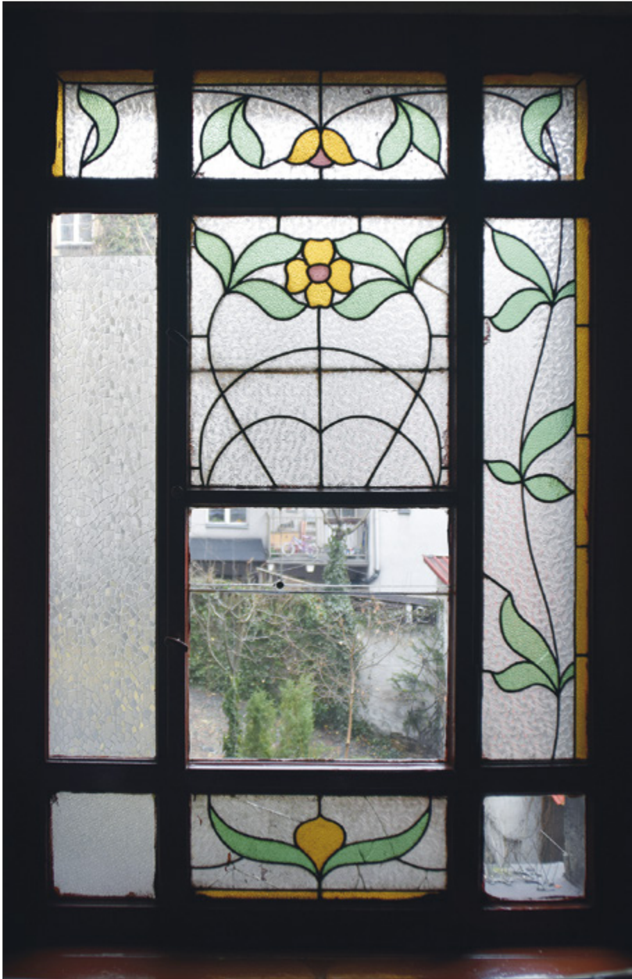
Il. 14. TORUŃ, ul. Poniatowskiego 3, secesyjny witraż okna klatki schodowej oficyny (szkło ornamentowe, listwy ołowiowe). Fot. A. Kaźmierczak
