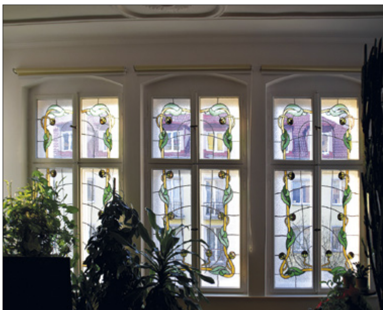
II. 13. TORUŃ, ul. Poniatowskiego 1, secesyjne witraże okien mieszkania (szkło opalowe, ornamentowe, walcowane bezbarwne okienne, listwy ołowiane). Fot. A. Kaźmierczak
