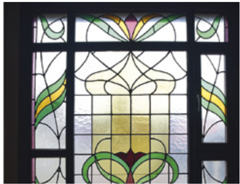
II. 10. Toruń, ul. Poniałowskiego 3, secesyjny witraż nadświetla drzwi wejściowych (szkło opalowe, katedralne, ornamentowe, listwy ołowiowe). Fot. A. Kaźmierczak
