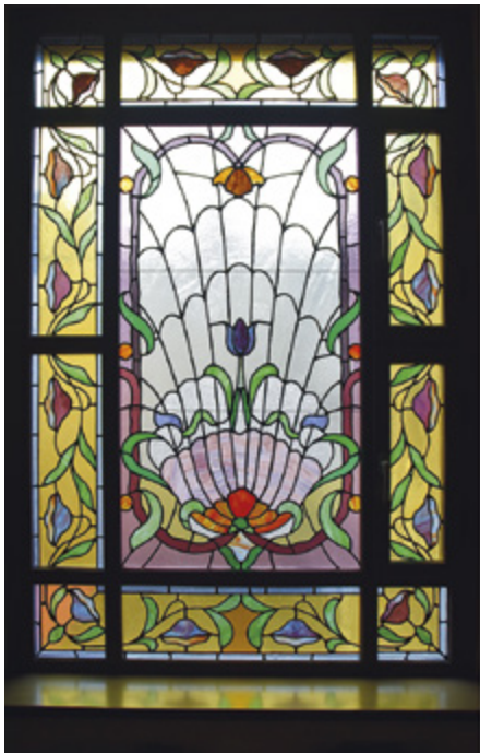
II. 11. TORUŃ, ul. Poniałowskiego 3, secesyjne witraże okien klatki schodowej (szkło opalowe, katedralne, ornamentowe, gomółkowe, listwy ołowiowe). Fot. A. Kaźmierczak
