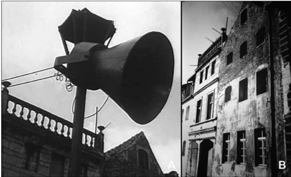
Il. 12. TORUŃ, ul. Podmurna 7, A) kadr filmu pt. „Prawo i pięść” w reżyserii Jerzego Hoffmana i Edwarda Skórzewskiego z 1964 roku z widocznym fragmentem budynków; B) fotografia z l. 70. XX wieku ukazująca klasycyzujący budynek zwieńczony tralkową attyką oraz dawny spichlerz.
