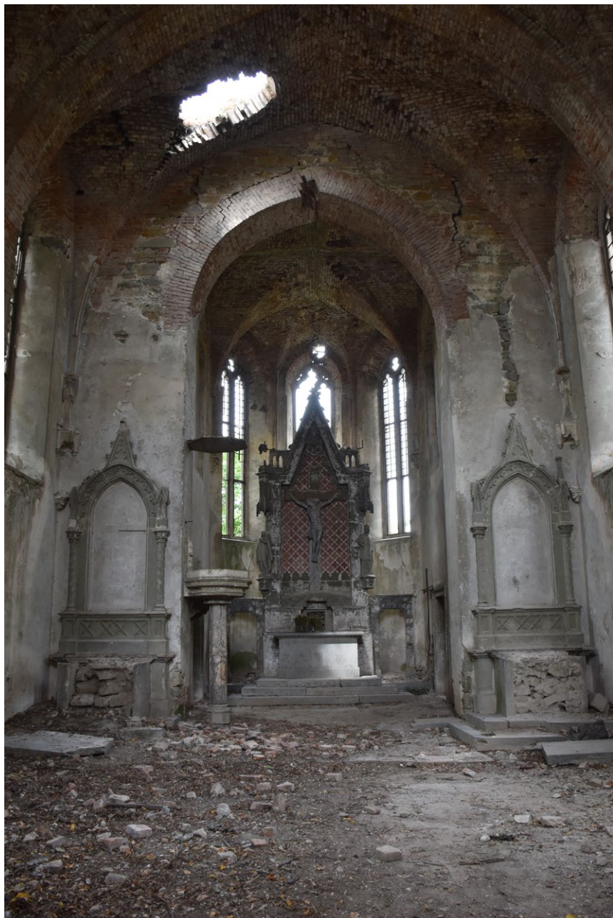
Il. 11. Turylcze, dawny kościół parafialny, widok w stronę prezbiterium. Fot. A. Dworzak, 2019
