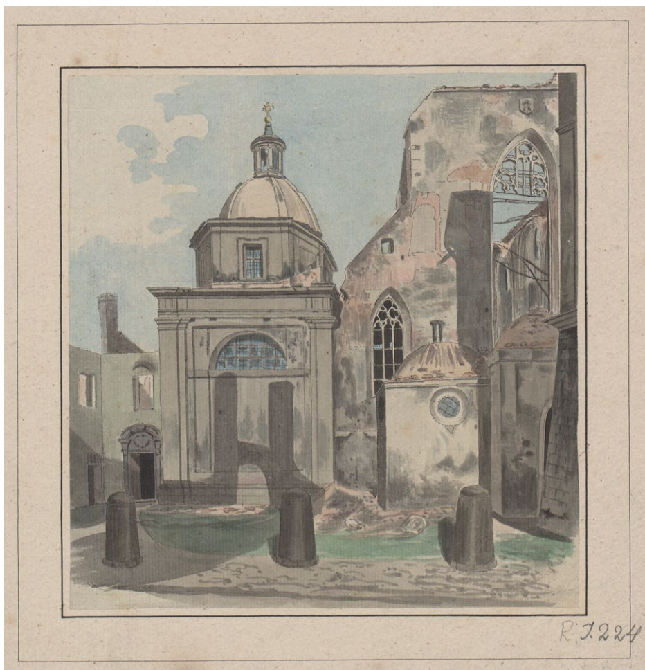
Il. 6. Bogumił GAŚSIOROWSKI, Kościół Dominikanów w Krakowie po pożarze (północna część fasady z kaplicą Zbaraskich), 1850 r. Fot. Biblioteka Jagiellońska, Zbiory Graficzne, IR 224
