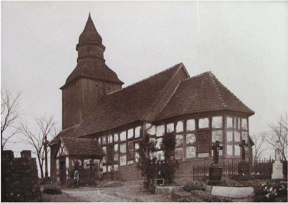
II. 7. Kościół pw. św. Katarzyny w Sławęcinnie. Fotografia wykonana w związku z planem rozbudowy zabytku, w celu umożliwienia konserwatorowi oceny jego wartości bez przeprowadzenia inspekcji terenowej. Widok od południowego wschodu, 1931 r. Fot. wg APB, UWPT, sygn. 24107
