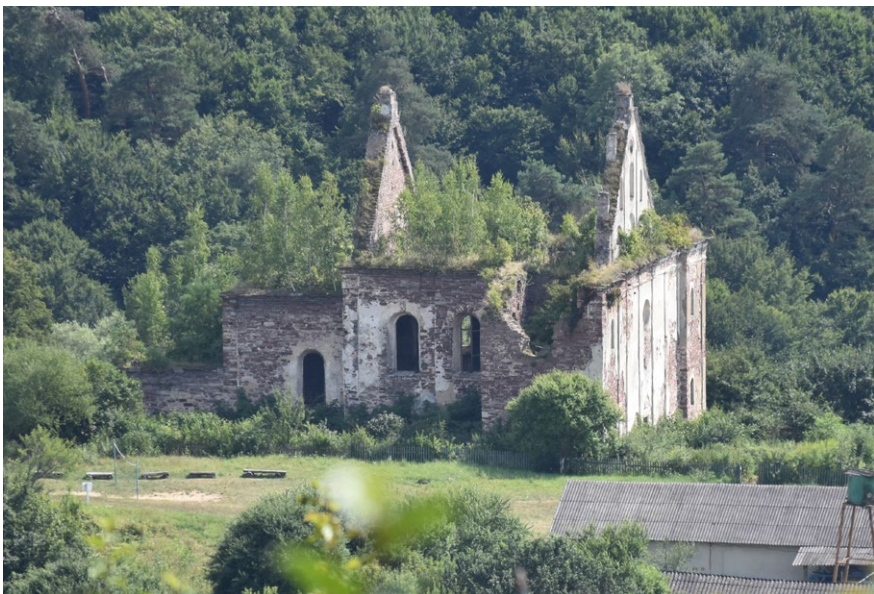
Il. 10. Czerwonogród, dawny kościół Dominikanów. Fot. A. Dworzak, 2019
