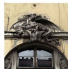
dekoracje plastyczne elewacji
